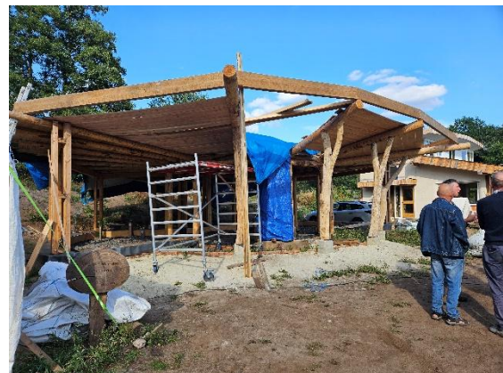
Foto 2: woning in aanbouw.
