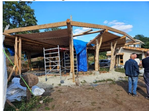
Foto 2: Wohnung im Bau.
