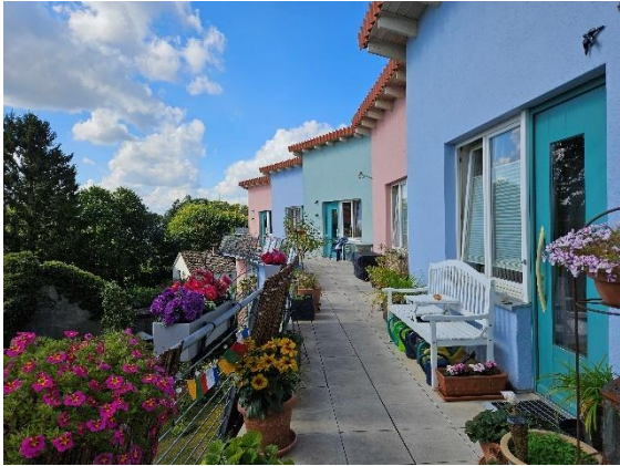
Foto 5: Breite Galerien bieten zusätzlichen Außenraum.
