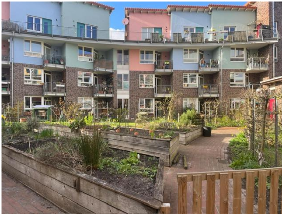
Foto 1: Impressie gebouw met binnentuin
